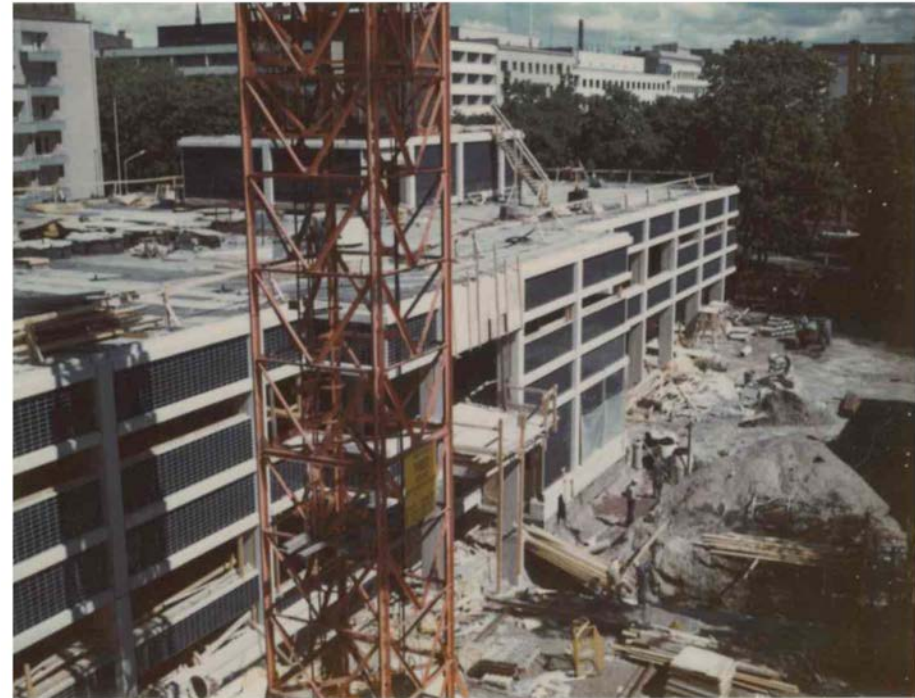
Kuva työmaalta / PTT
