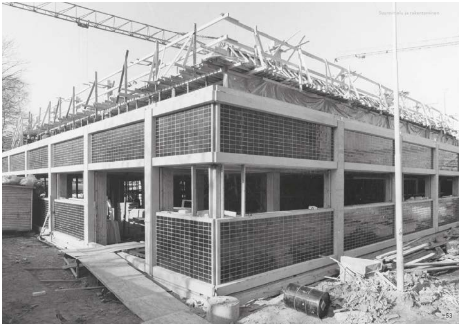
Kirjaston ensimmäisen kerroksen elementit ovat jo paikoillaan, ylempiä kerroksia valetaan. / 1975 / Sven Raita / SM
