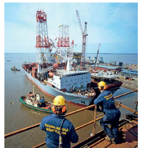
Porauslaivat rakenteilla kesällä 1982. Kuva: Pentti Valmunen. Rauma-Repolan kuvat / Sata Shipbuilding Oy.
